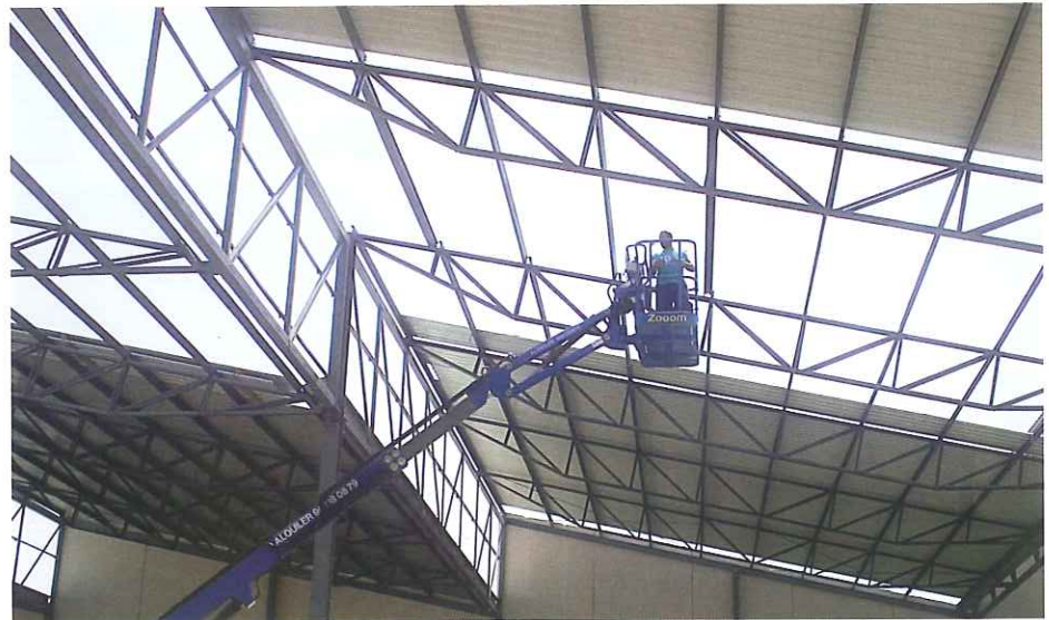
Aspecto general de una Nave Industrial, en el proceso de inspección del montaje de la cubierta, previsto dentro del Plan de Control Integral
