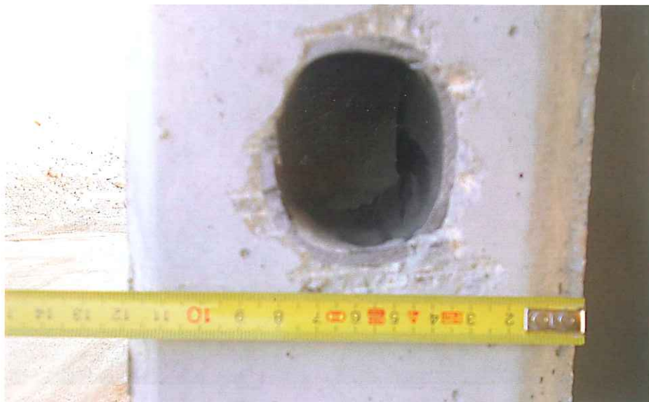
Comprobación de las características geométricas de las placas prefabricadas de hormigón, utilizadas para cerramientos e inspección de sus puntos de anclaje, como elementos singulares
